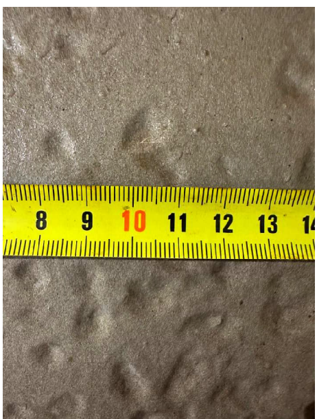
Foto 35 – Důlková koroze s pr. 5-10 mm
