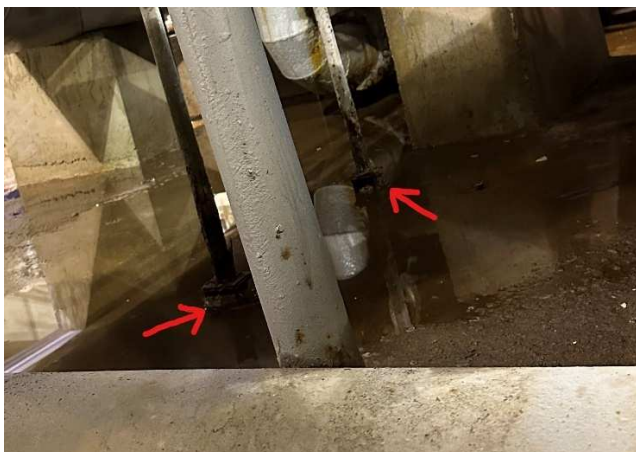
Foto 1 – Kaluže vody působící na svislé prvky
