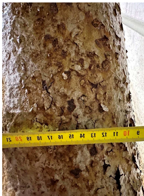
Foto 30 – Silná degradace prorezavěním
