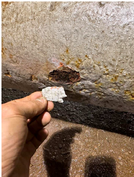
Foto 33 – Korozní produkty
