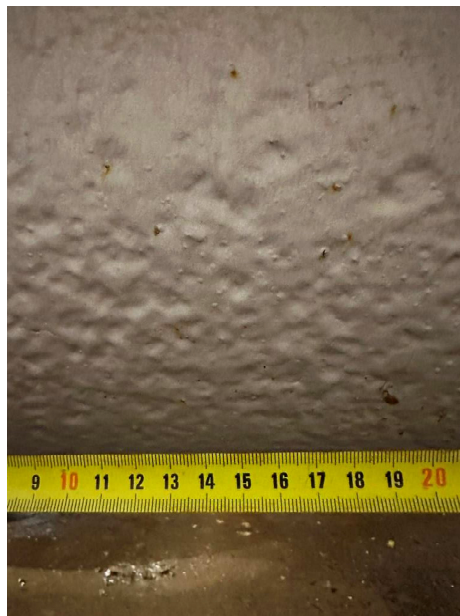
Foto 28 – Původní důlková koroze
