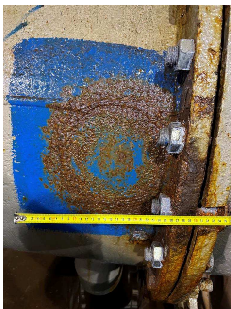
Foto 17 – Koroze na svaru (Ri5)
